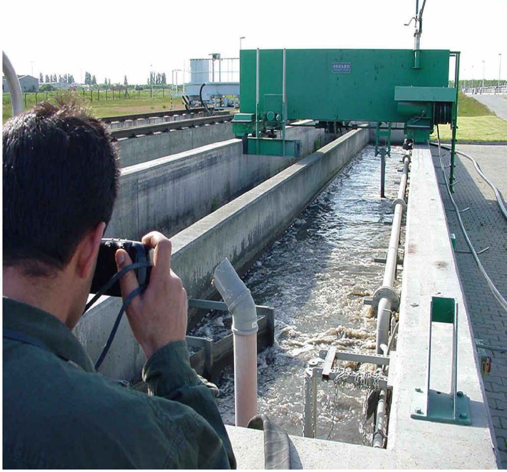
الصورة رقم (٨): محطة معالجة للعصارة السوداء في مكب النفايات الصحي [٤٩].
