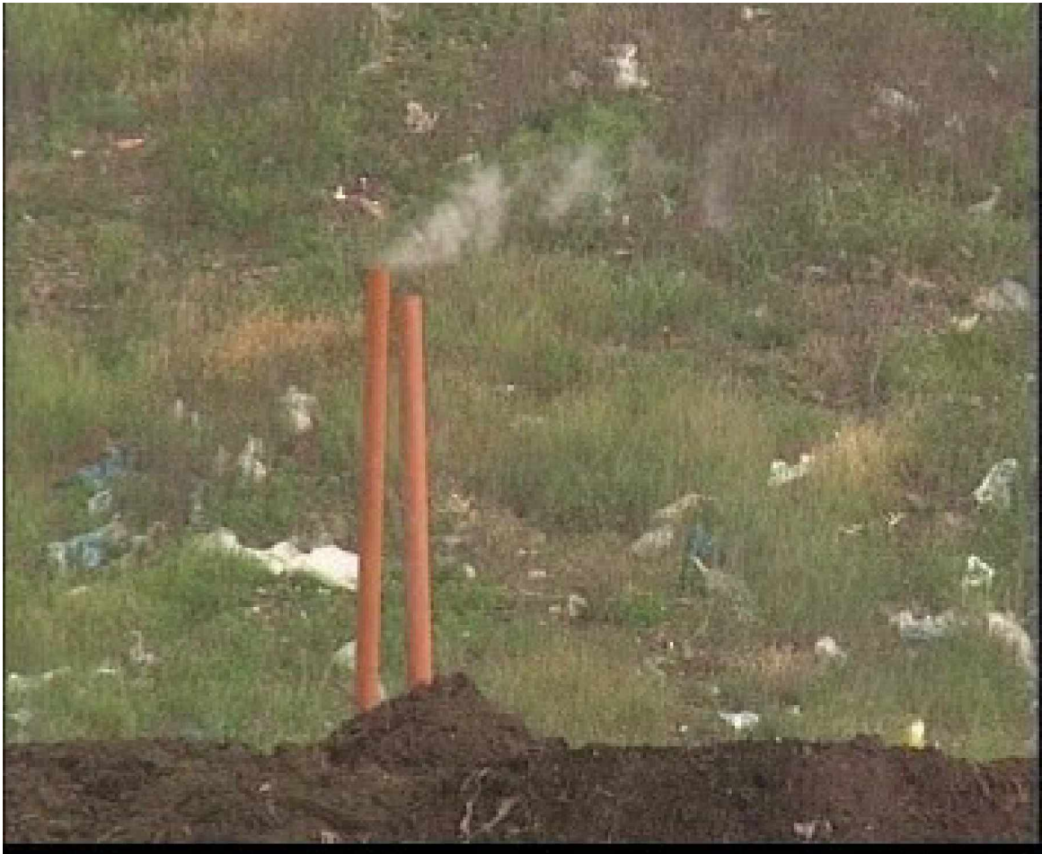
الصورة رقم (١٠) : انبعاث الغاز من مكب النفايات، عبر أنابيب تجميع الغاز [٤٩].
